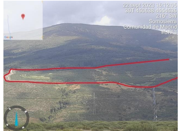
Zona de trabajo 1432402 NA, desbroce mecanizado apoyado en borde oeste del pinar del MUP 162.
